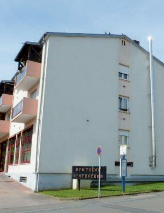
Nouvelle chaufferie au Foyer Hohenbourg et sa cheminée d'extraction
