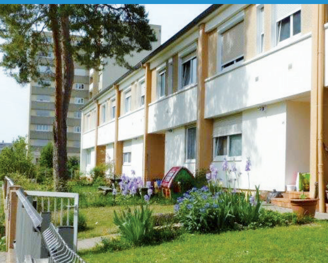
Les pavillons Place de Gail équipés de nouvelles chaudières individuelles
